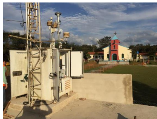
Figura 3.4-2 – Estação convencional em Córrego do Feijão
