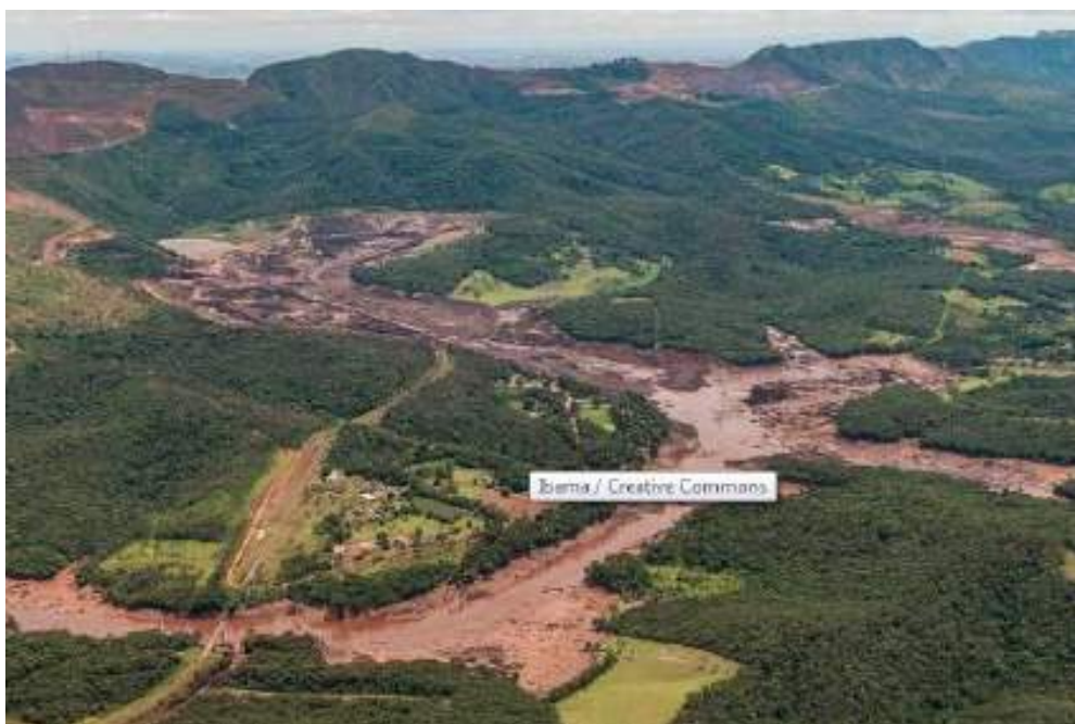
Figura N°1: Imagem da área soterrada após desastre da barragem. Fonte: IBAMA (2019).
