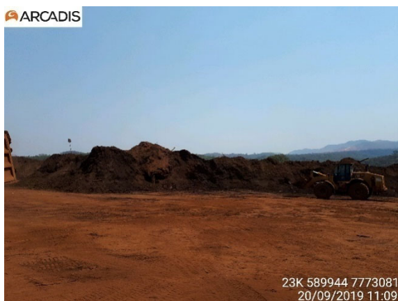
Figura 13 – Rejeito removido e disposto em pilhas no Depósito temporário “Ponto 9”
