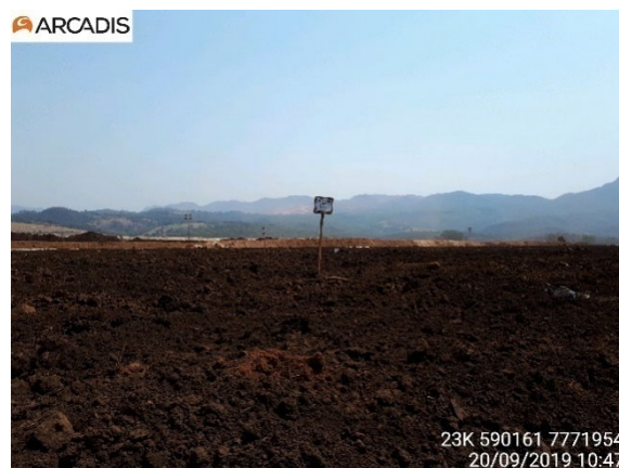
Figura 14 – Rejeito removido e disposto em leiras no Depósito temporário “Ponto 8”
