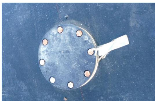
Figura 2-9: Ponto de amostragem, flange de inspeção
