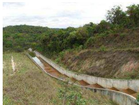
Foto 2-11: Entrada do Vertedouro – Barragem Menezes II –
