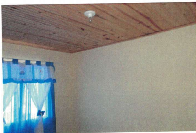
Figura 3 – Interior da edificação
