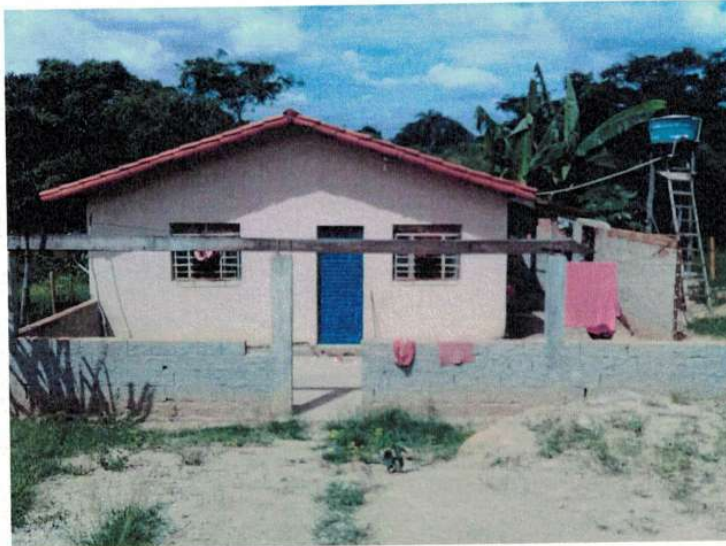
Figura 1 – Fachada frontal da edificação.
