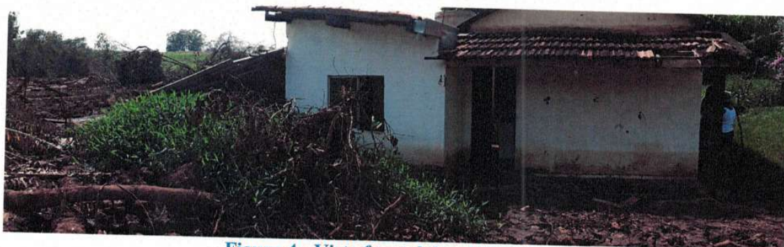
Figura 4 - Vista frontal da edificação
