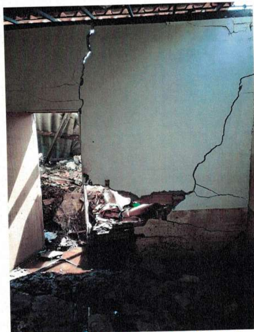
Figura 2 - Vista interna da edificação
