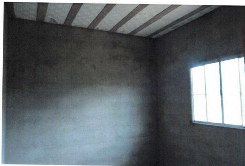
Figura 3 – Interior da edificação
