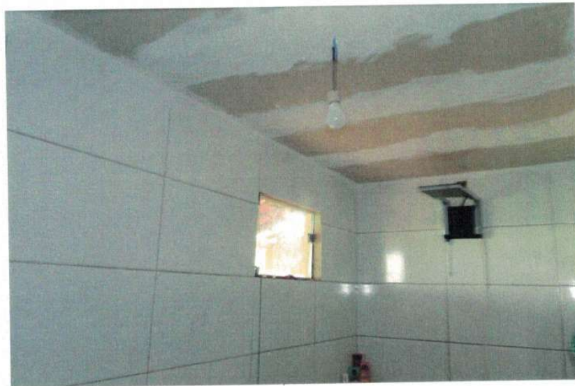
Figura 2 –Interior da edificação
