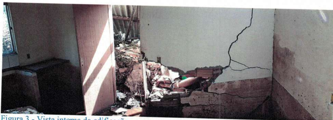
Figura 3 - Vista interna da edificação
