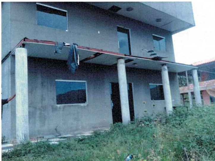
Figura 1 – Vista da fachada frontal
