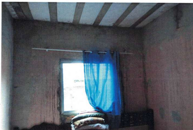
Figura 3 – Interior da edificação
